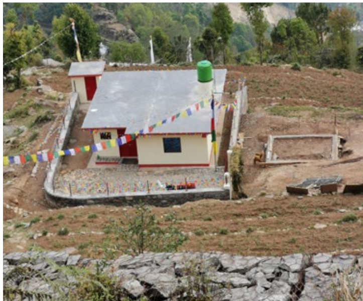
Bau eines Gesundheitszentrum in Nepal
