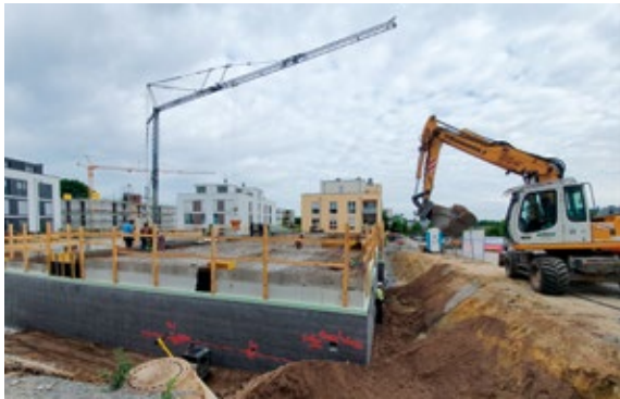
Trotz Corona Lockdown läuft unsere Baustelle planmäßig
