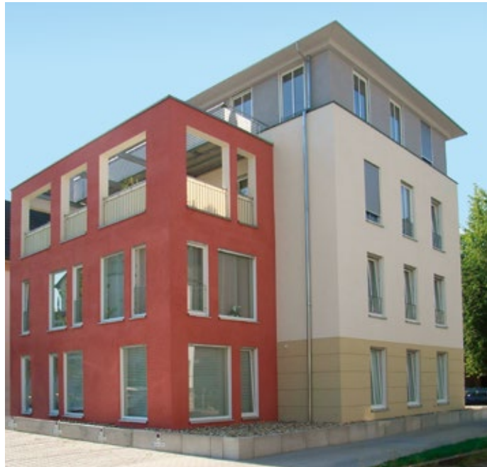
Bestandsgebäude Ooser Bahnhofstraße 17a
