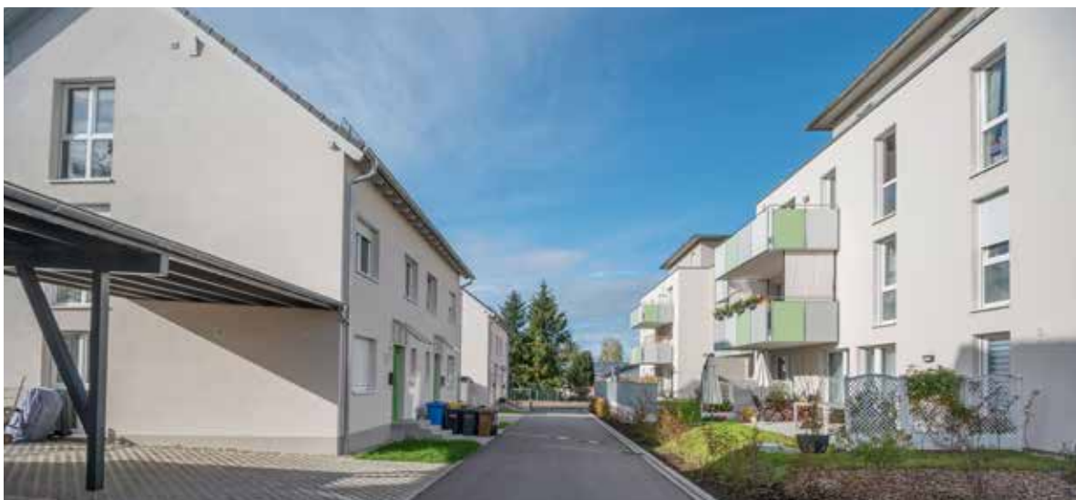
Doppelhäuser Darnieweg mit Mehrfamilienhaus Bahnhofstraße 57c/d
