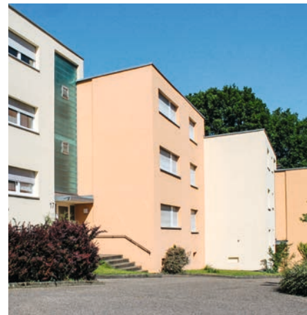
Nach Fassadenreinigung: Hochstraße 17/19
