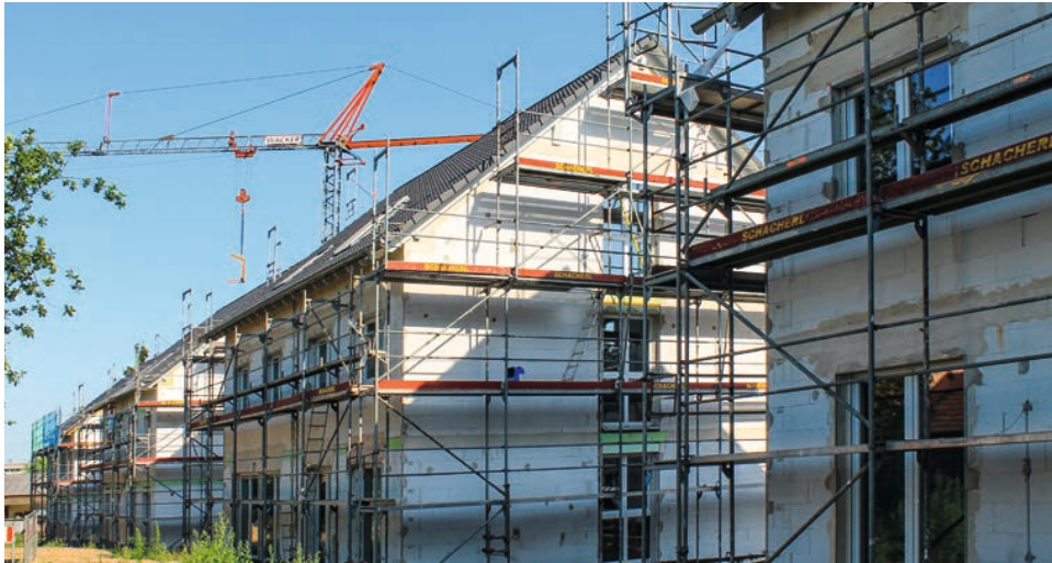
Blick auf die Baustelle: Doppelhäuser Darnieweg 1 – 1g
