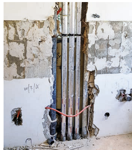
Austausch der Steigstränge im Rahmen einer Wohnungsmodernisierung
