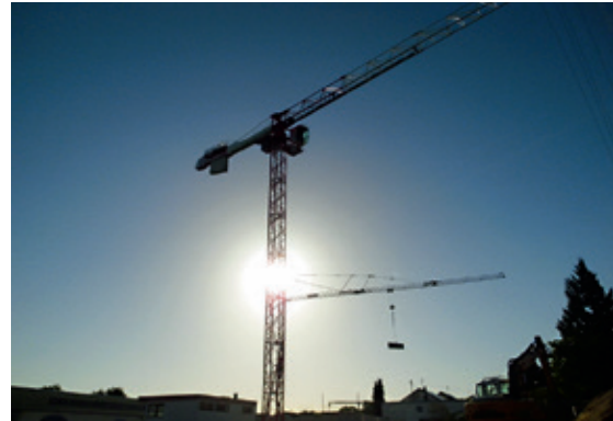
Bahnhofstr. 57 c/d – Blick auf die Baustelle
