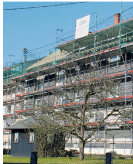
Pfrimmersbachgasse 1 a/b – Fassadenarbeiten
