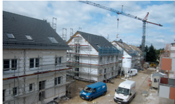
Darnieweg 1 - 1g – Blick auf die Baustelle
