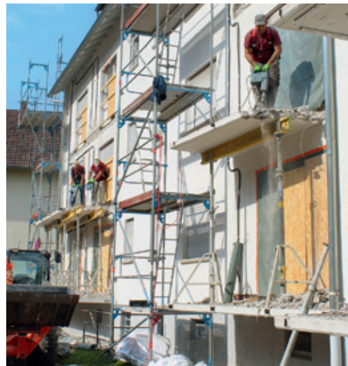
Sanierung Pfrimmersbachgasse 1 a/b – Abtrennen der alten Balkone
