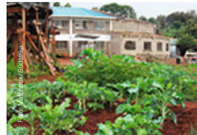
Schule mit Erweiterung im Rohbau mit Schulgarten
