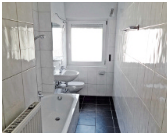
Bad nach Modernisierung
