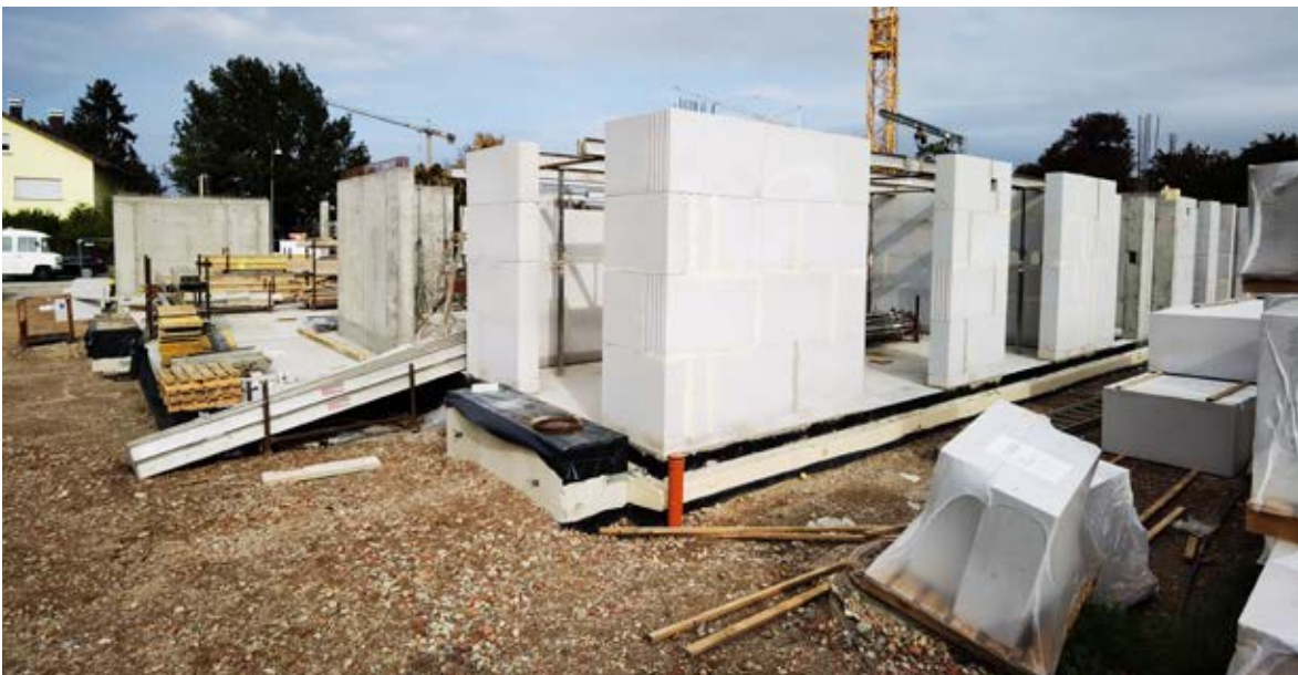
Kuppenheimer Straße 26 – der Rohbau ist in Arbeit.
