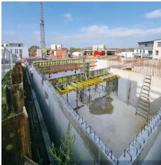
Während der Bauphase im Oktober 2022
