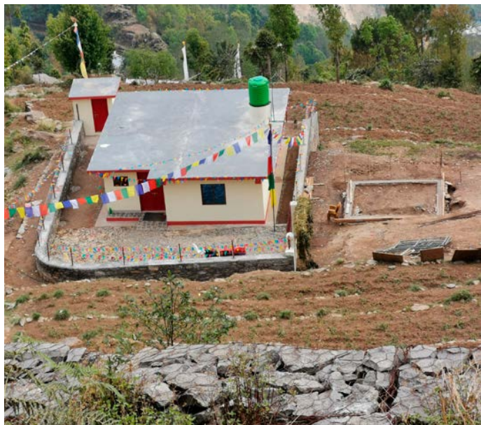
Bau eines Gesundheitszentrum in Nepal
