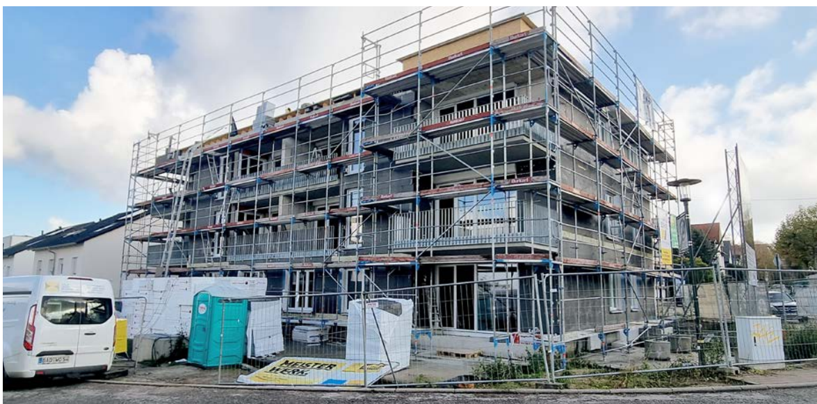
Der Rohbau steht.
