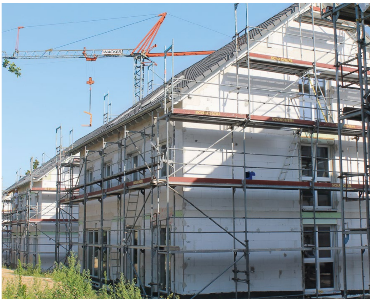
Im Bau: Doppelhäuser Darnieweg, Ansicht Terrassenseite
