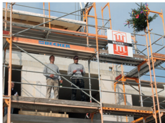
Zimmermann Simon Baumann hält den Richtspruch
