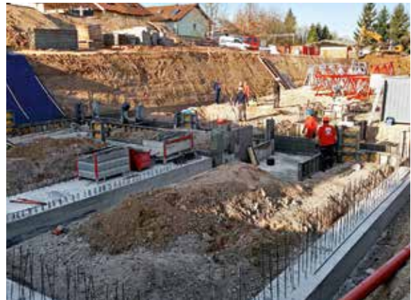
Auf unserer Baustelle in der Bahnhofstraße 57c/d wird kräftig gearbeitet
