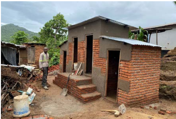
Lokale Handwerker und Familien arbeiteten gemeinsam am Bau der Trockentrenntoiletten, hier zwei Toiletten. Foto: DESWOS
