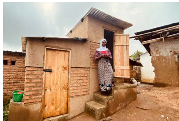
Bewohnerin steht vor einer gerade fertig gestellten Trocken-trenntoilette. Foto: DESWOS
