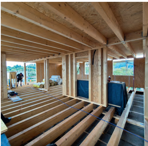
DG Ausbau Ooser Waldstraße 3/5
