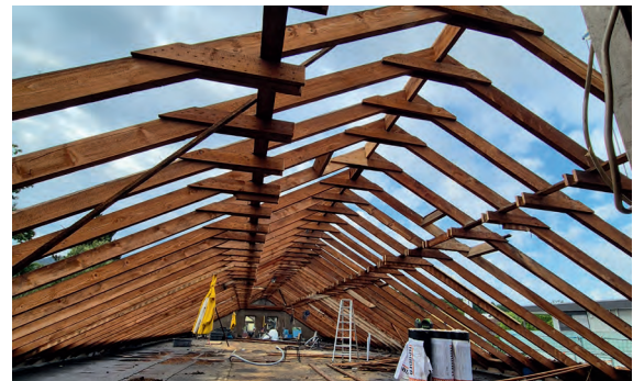
Abbruch altes DG Ooser Waldstraße 3/5
