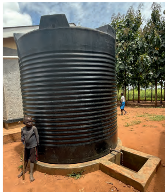
DESWOS: Wassertank zur Versorgung der Schulkinder Lehrkräfte mit Trinkwasser
