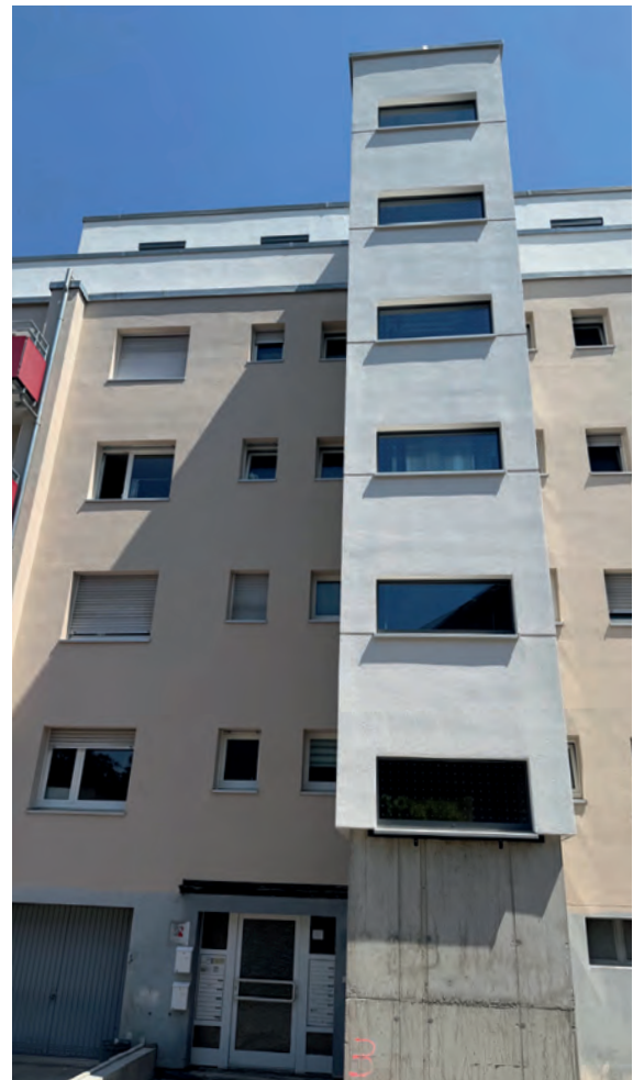
Ooser Waldstraße 3/5 – Neu entstehender Aufzugsturm
