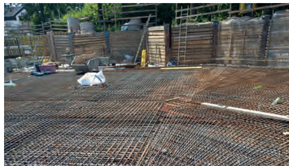
Baustelle Stöcke Nord
