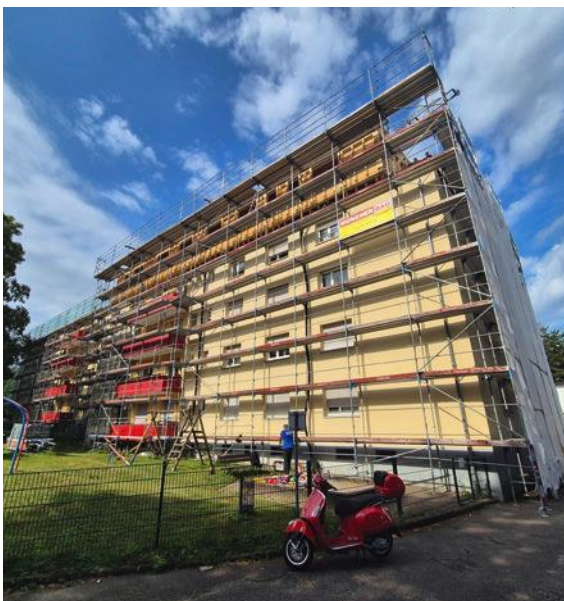
Ooser Waldstraße 3/5 – Gebäude in eingerüstetem Zustand
