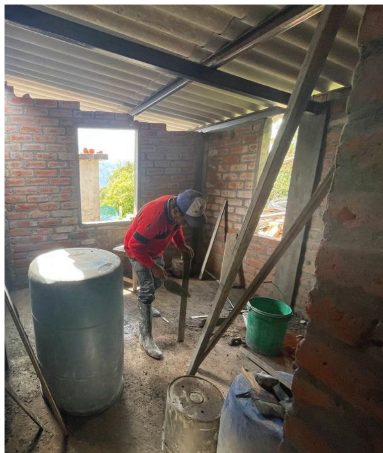
DESWOS: laufende Bauarbeiten im Kanton Penipe Ecuador
