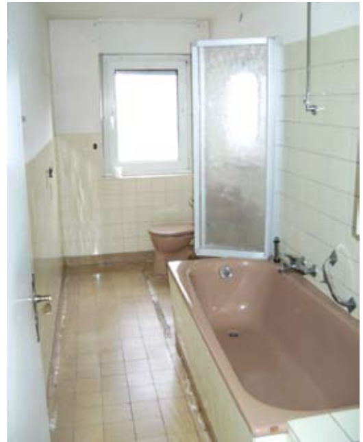
Bad vor der Modernisierung
