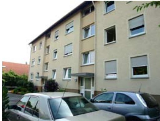
Danziger Straße 32/34 vor der Modernisierung
