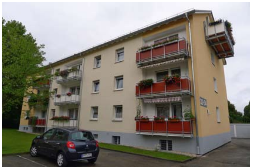
Danziger Straße 32/34 nach der Modernisierung
