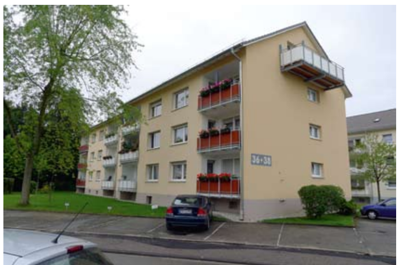
Danziger Straße 36/38 nach der Modernisierung
