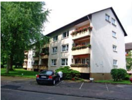
Danziger Straße 36/38 vor der Modernisierung
